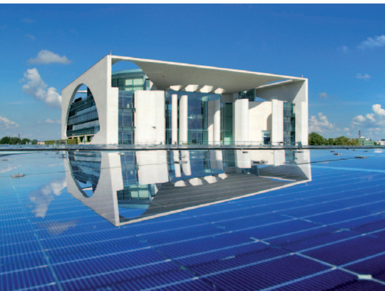
Solaranlage auf dem Dach des Kanzleramts. Der SFV fordert den schnellen Ausbau der Photovoltaik auf städtischen Dächern. Foto: BSW-Solar / Langrock
