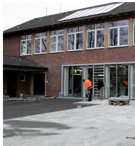
Gläserne Heizzentrale im Bau: Im Erdgeschoss des Schulzentrums in Saerbeck entsteht für alle Bürger sichtbar die neue Heizzentrale auf Basis von Holzpellets, die über ein Nahwärmenetz ein Schul- und Sportzentrum und einen Kindergarten versorgt. Die Heizkosten werden fast halbiert. Foto: Gemeinde Saerbeck
